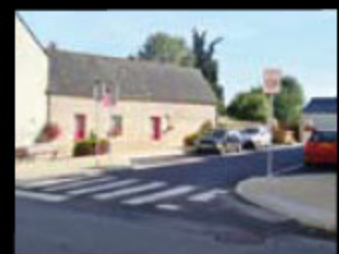
Aménagement rue des Bergères
