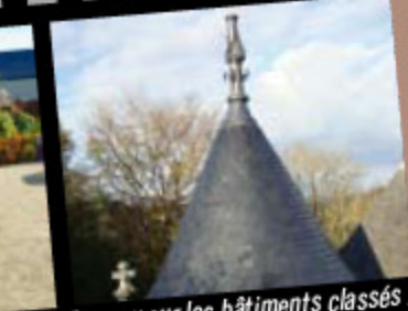
Travaux sur les bâtiments classés : St Barbe, les Halles, St Fiacre
