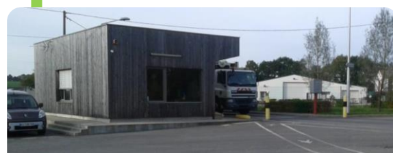
Vue générale de l'entrée du site (local et pont bascule) une Baie pour le stockage des déchets (pour les tous prochains)
