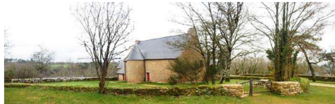
Photo 131 : L'arrière de la maison du garde de la chapelle Sainte-Barbe
