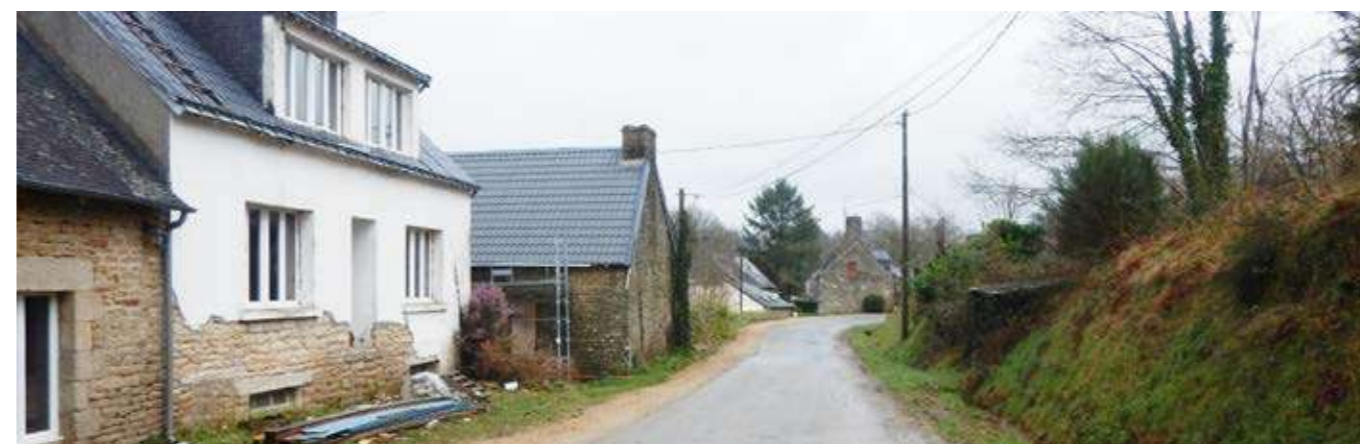
Photo 95 : Le hameau de Coat-en-Haie à l'implantation bâtie linéaire
