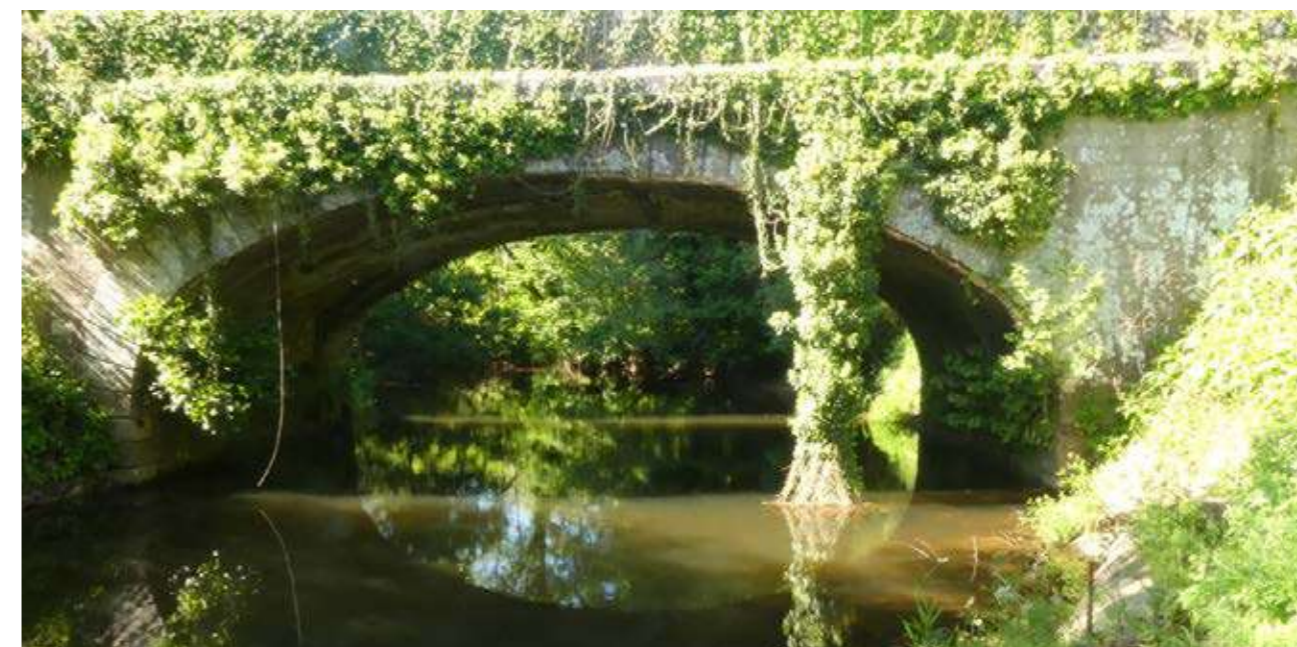
Photo 5 : Pont sur l'Inam sur la RD782 – Extrémité ouest du fuseau d'étude
