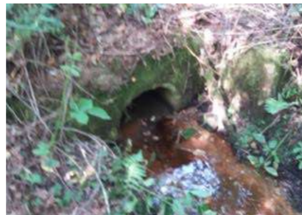
Photo 7 : OH-K-2 (Ø500) sous la RD 782
