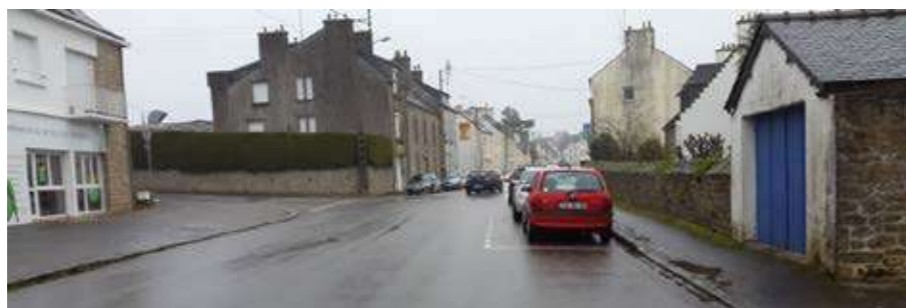
Photo 194 : La RD782 dans la traversée urbaine, entre Carrefour Market et la rue de la poste
