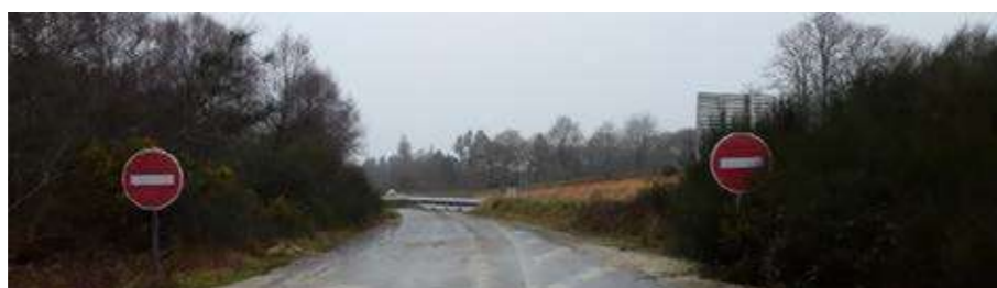
Photo 201 : L'ancienne bretelle de sortie de la RD769 vers le centre-ville de Le Faouët
