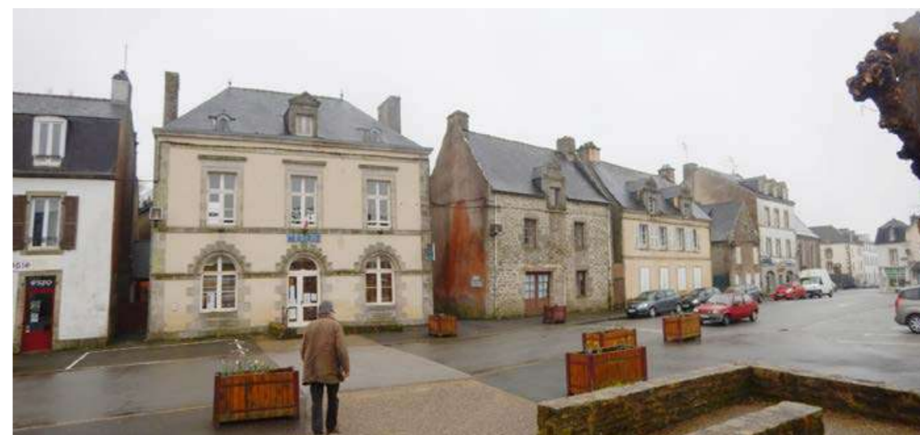
Photo 125 : Les lucarnes protégées d'une maison - deuxième à droite de la mairie
