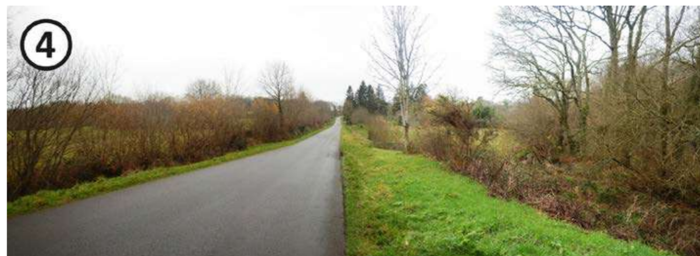
Photo 161 : Percées visuelles peu profondes depuis la rue de Saint-Fiacre au nord du fuseau étudié
