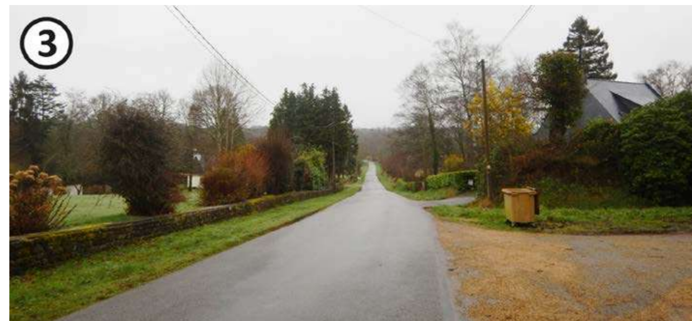
Photo 160 : La rue de Saint-Fiacre au niveau de l'intersection de la GR38
