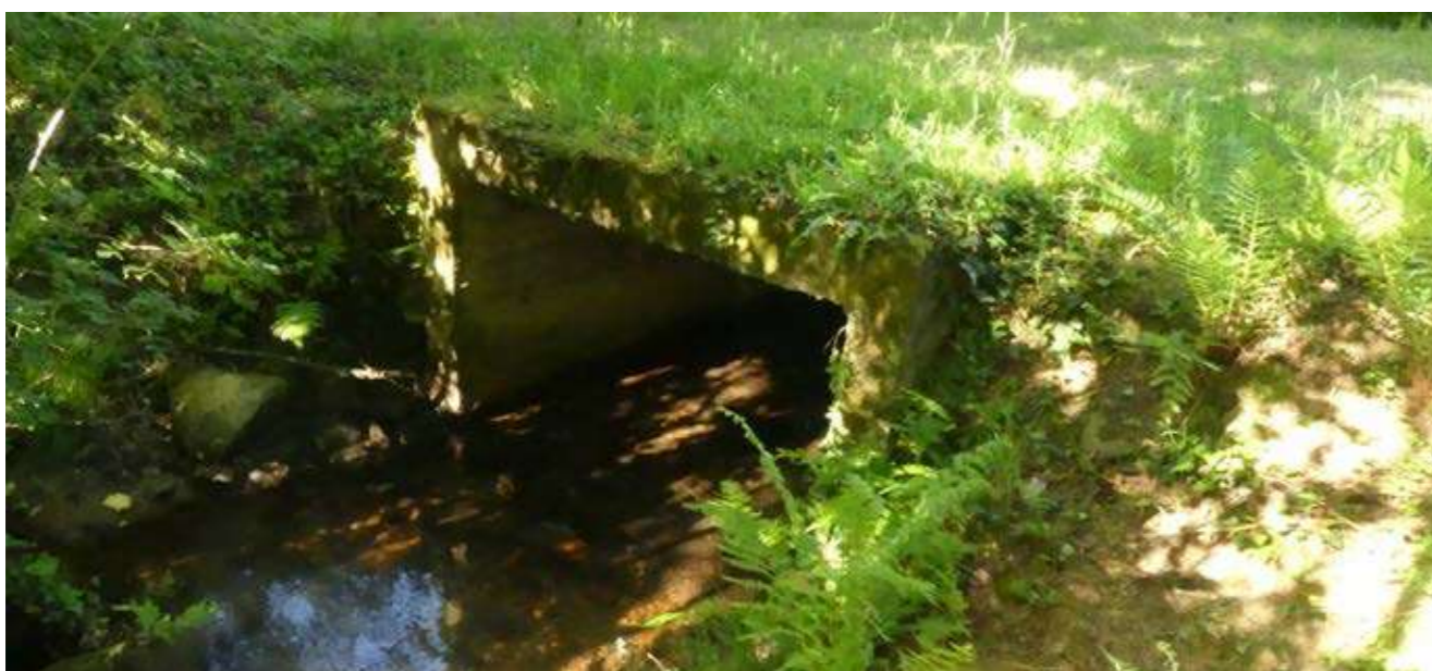
Photo 2 : OH-PC-1 (2,00 x 1,10) sous la RD 769
