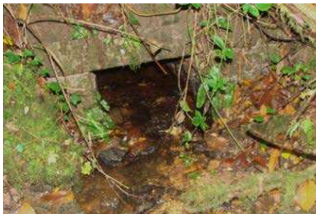
Photo 6 : OH-K-1 (0,70 x 0,55) sous la voie communale
