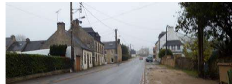
Photo 203 : La RD790 en entrée nord du centre-ville de Le Faouët
