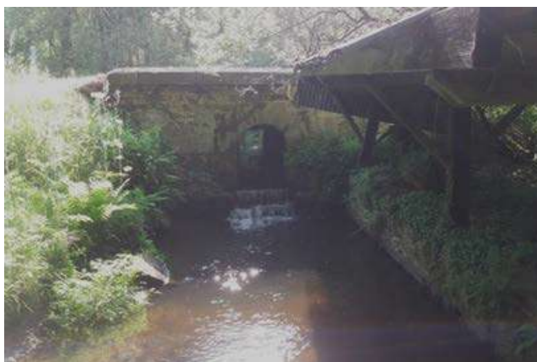
Photo 3 : OH-PC-2 (1,00 x 1,20) sous la RD 782
