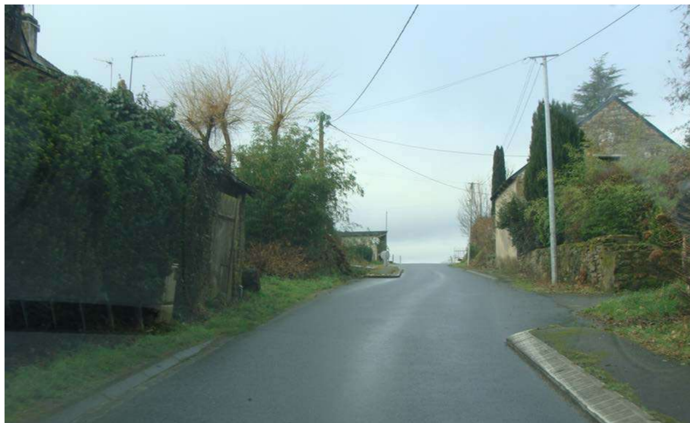
Photo 209 : Voie communale VC11 en traversée du hameau de Coat Loret
