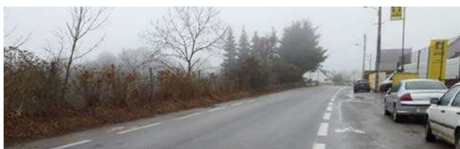
Photo 202 : La RD790 au nord du centre-ville de Le Faouët
