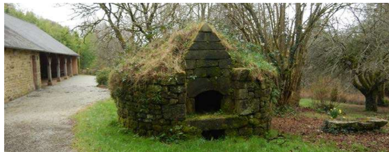
Photo 136 : Le Four à pains du hameau de Kercadoret
