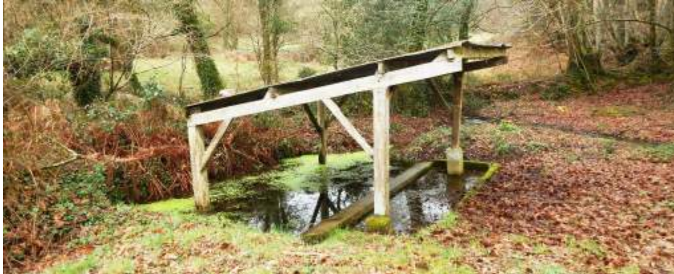
Photo 148 : Le lavoir de la ville de Le Faouët
