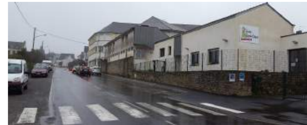
Photo 209 : La RD782 rue de Lorient au droit du collège Sainte-Barbe et de l'école du Sacré-Cœur
