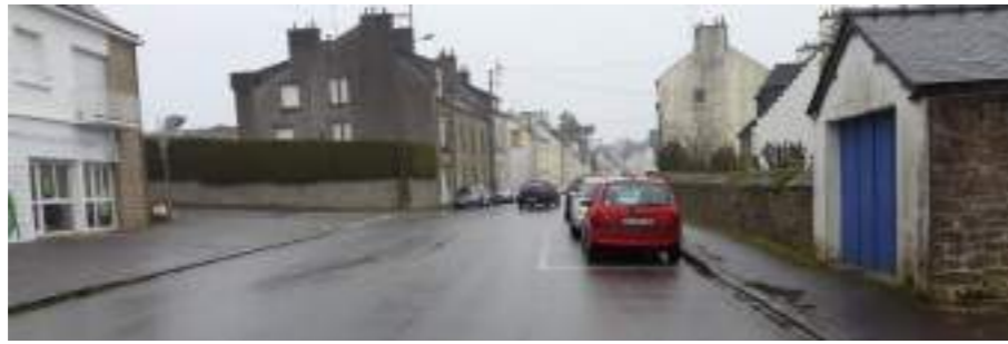
Photo 205 : La RD782 dans la traversée urbaine, entre Carrefour Market et la rue de la poste
