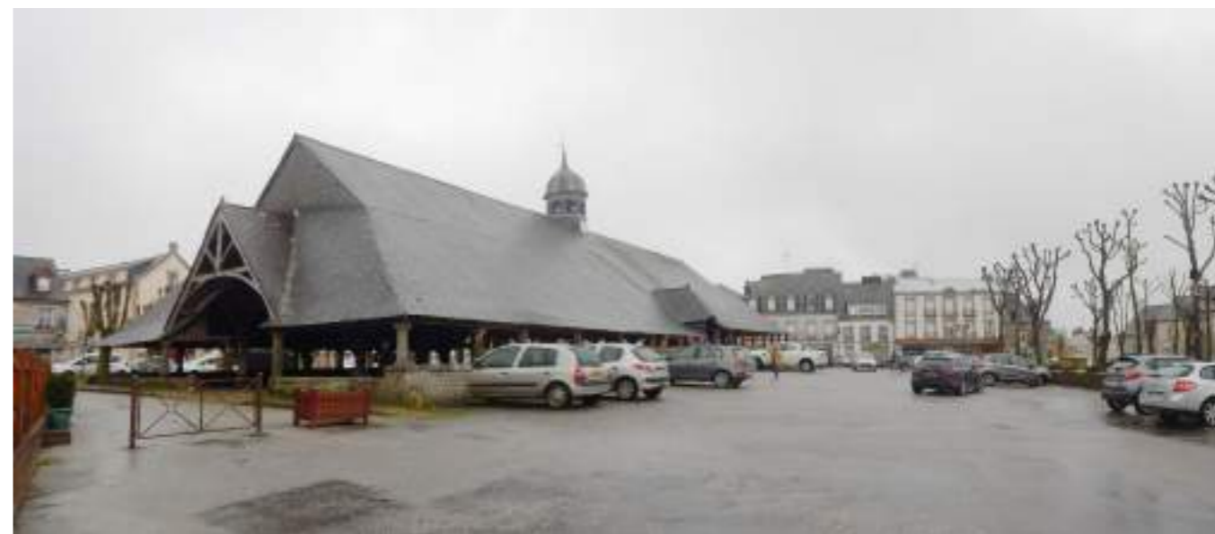
Photo 121 : Les vieilles halles de Le Faouët située au centre de la ville
