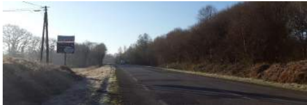
Photo 1 : La RD769 en contournement du centre-ville de Le Faouët
