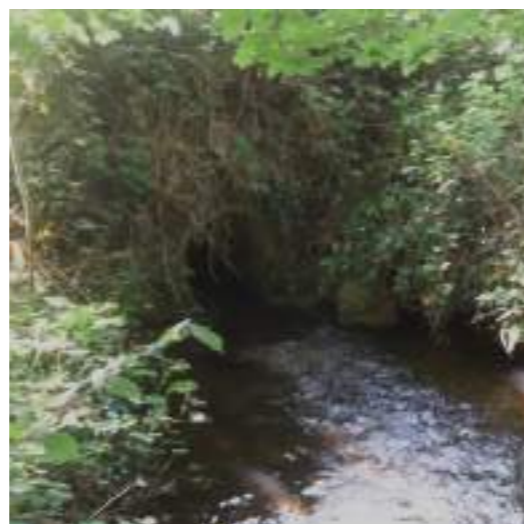
Photo 5 : OH-PC-4 ( \varnothing 600) sous voie communale
