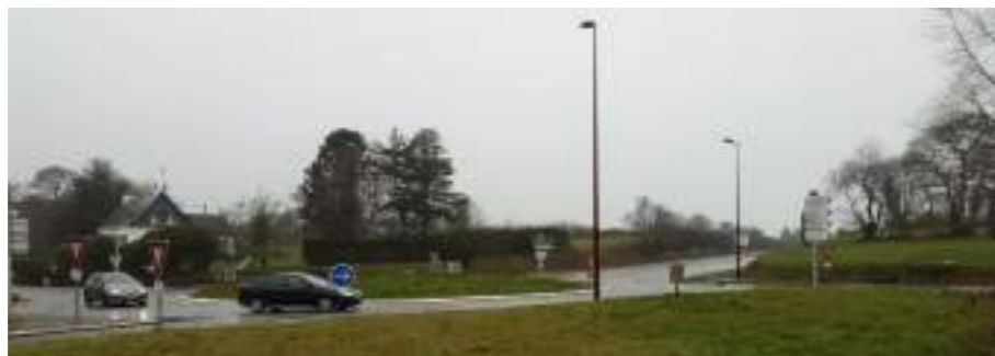
Photo 211 : Le carrefour giratoire RD769/RD790
