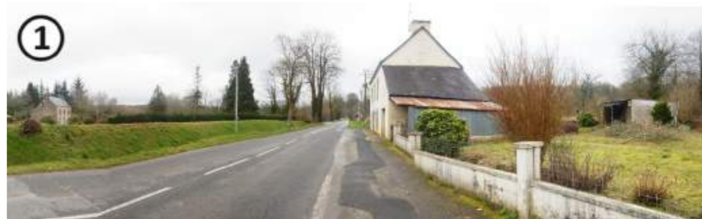
Photo 165 : Hameau de Pont er Lann depuis la RD782 en direction de la RD769
