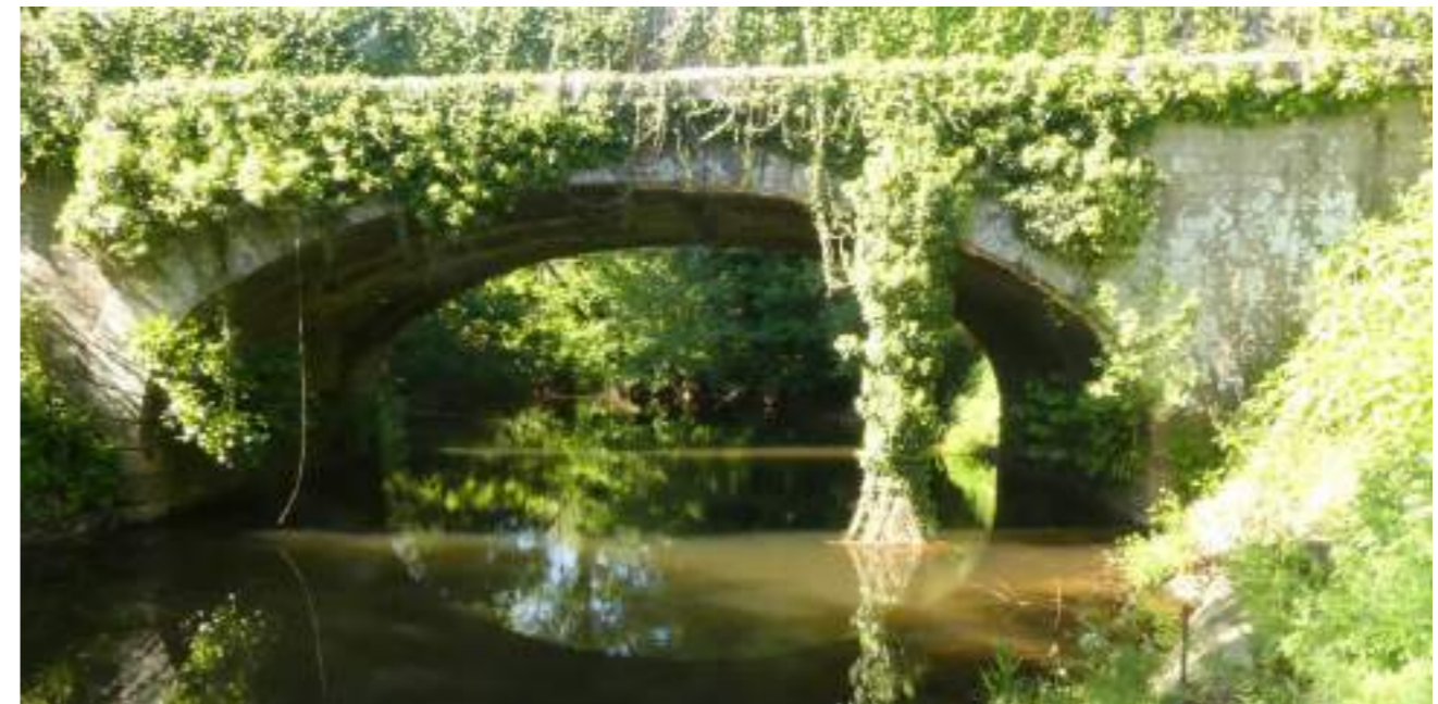
Photo 6 : Pont sur l'Inam sur la RD782 – Extrémité ouest du fuseau d'étude
