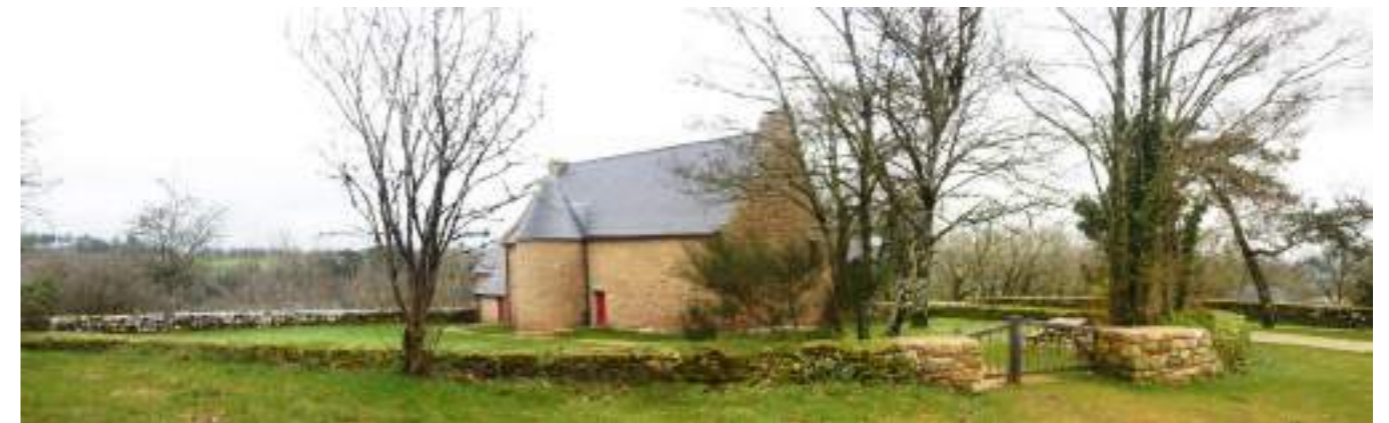
Photo 142 : L'arrière de la maison du garde de la chapelle Sainte-Barbe
