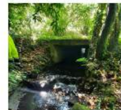
Ouvrage de franchissement de la RD 769 (aval)
