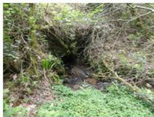
⑥ Ouvrage de franchissement du Kerly
