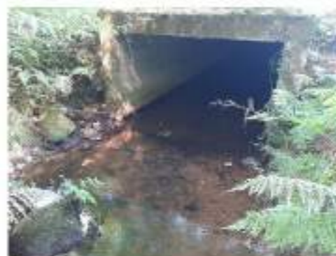
Ouvrage de franchissement de la RD 769 (amont)
