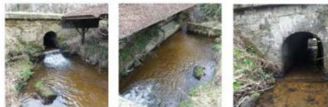
Ouvrage de franchissement de la RD 782 (chute aval ± 50 cm et plat courant amont)
